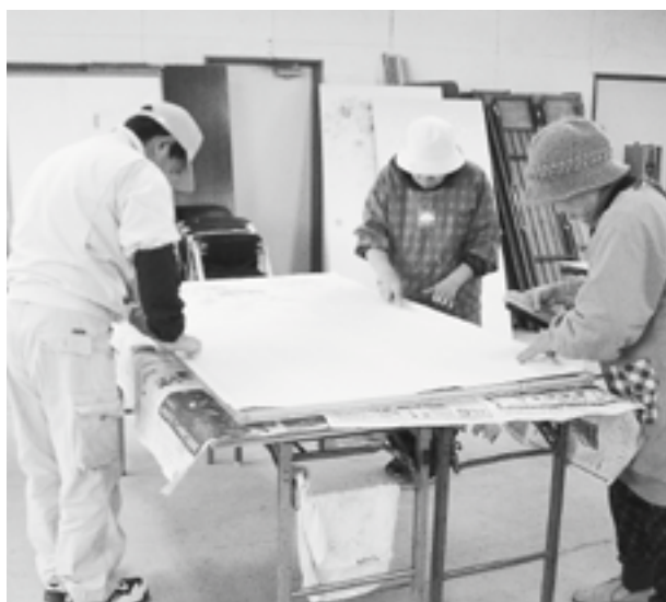
ふすま張り作業、丁寧に仕上げています。
