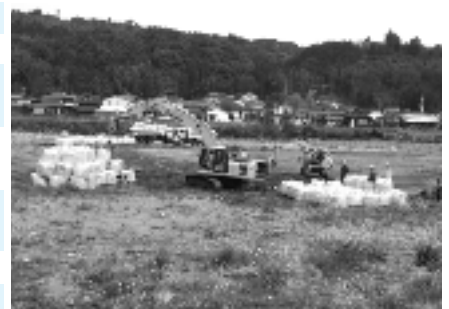
③土のう積作業中
