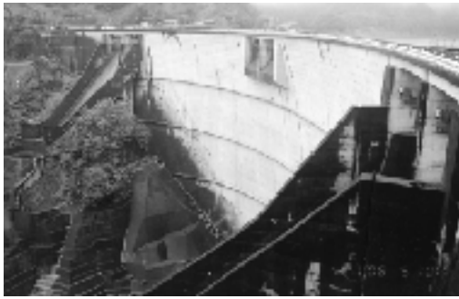
堤高、総貯水量とも九州最大の一ツ瀬ダム
