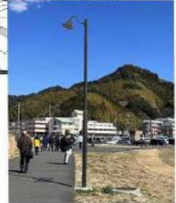
遊水地再帰遊歩への照明灯設置
