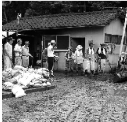
地元住民による堆積土砂の取り除き作業
