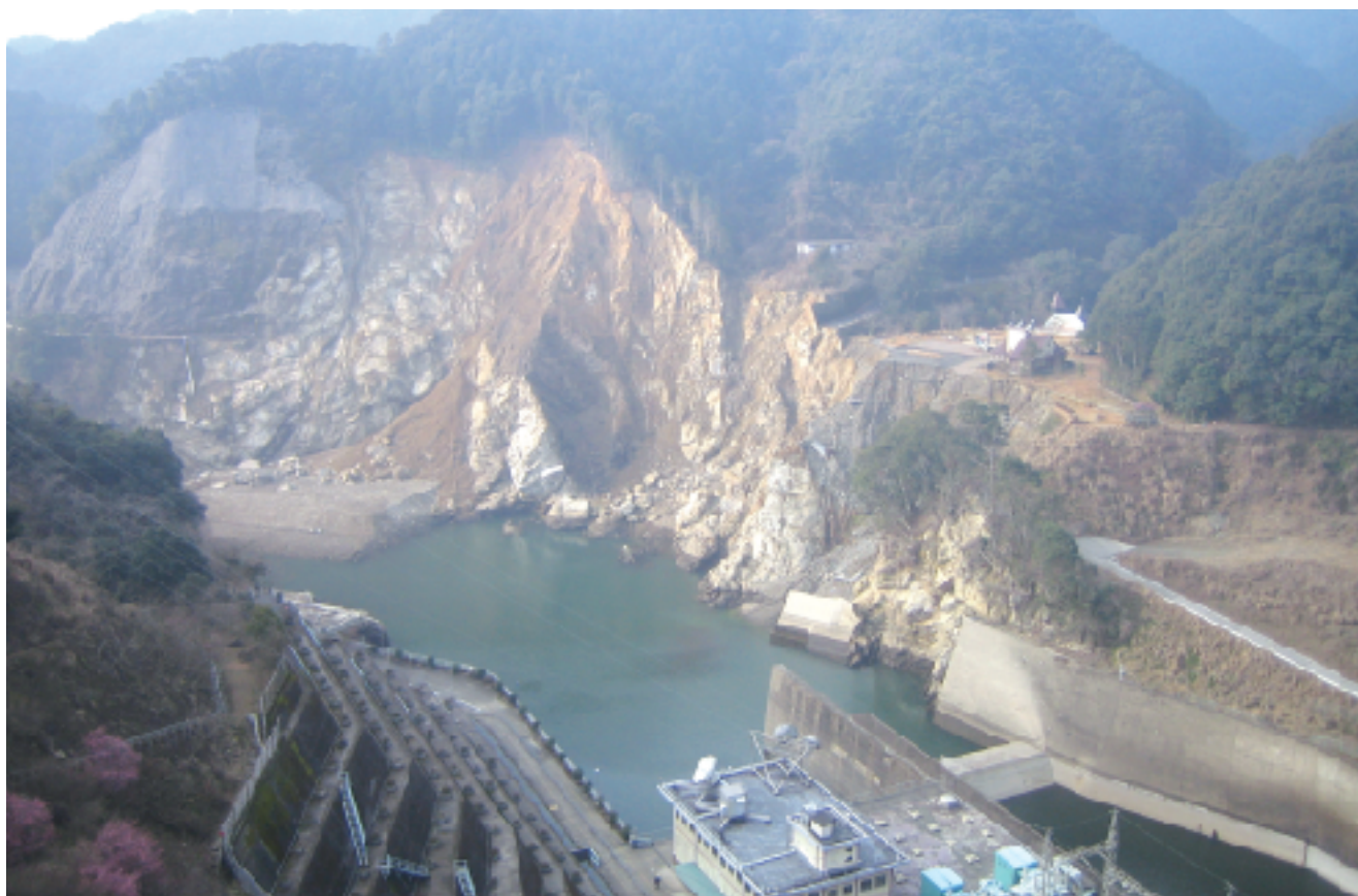
上記の写真は、ダム堤から緊急放水により正面の山腹崩壊を招いたものである。あらためて、水の脅威を目の当たりにした。
