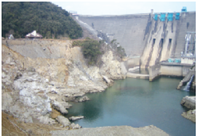
下流から見たダム堤体と山腹崩壊
