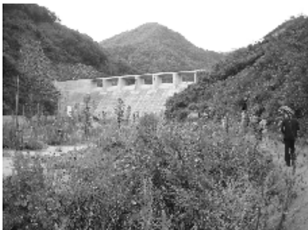
①下流から見たダム全体
