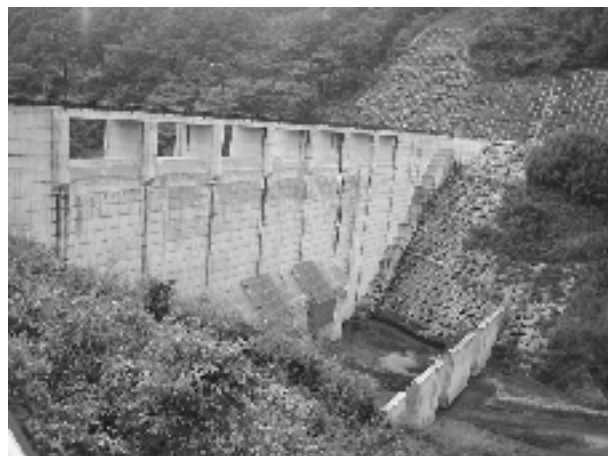
②ダム内側、全貌
