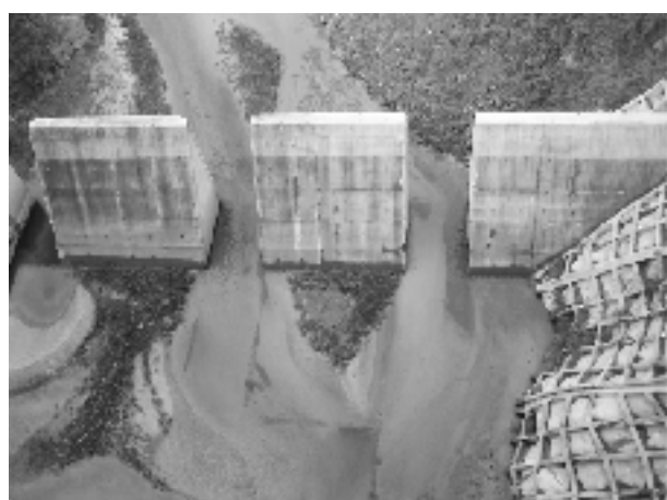
④上から見た流石、流木止め
