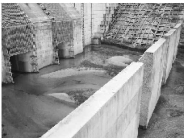
③ダム内側常用洪水吐き（2箇所） 及び流石、流木止め周辺
