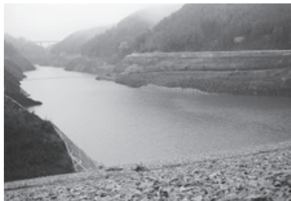
大蘇ダムえん堤からダム湖上流を見る
