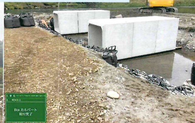
仮橋の土台ボックスカルバート
