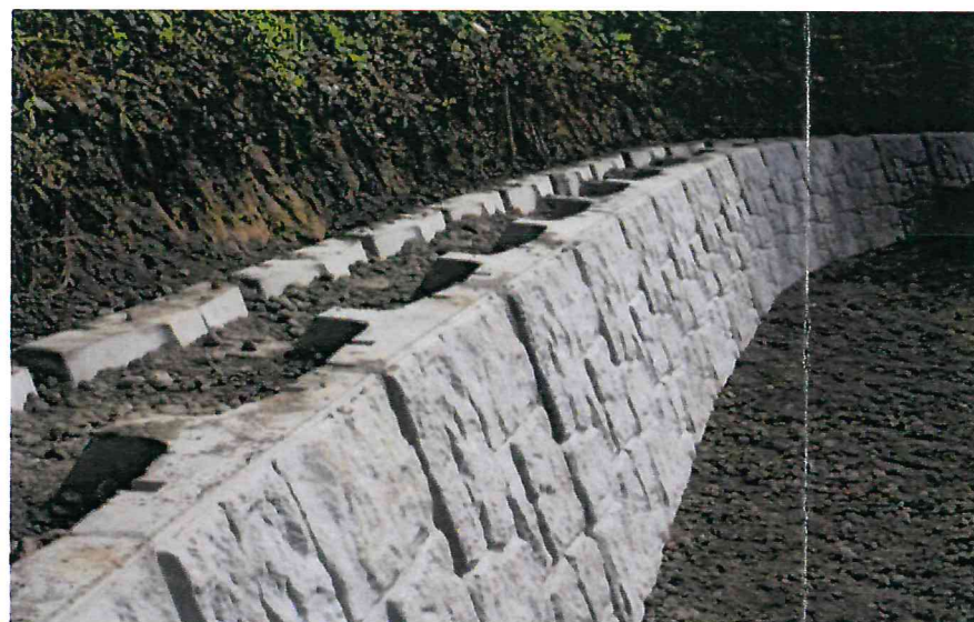
施工例：大型ブロック積
