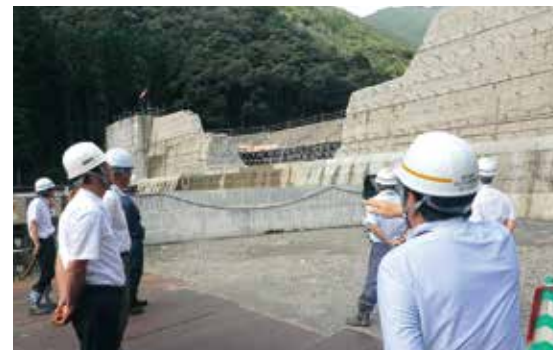
改築が進められている横手谷砂防堰堤（五木村）を視察
