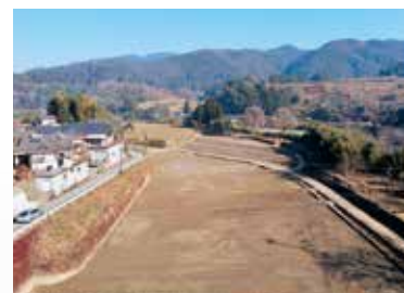
農地の災害復旧工事 （四浦平川地区）
