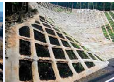
林道の災害復旧工事 （四浦椎葉地区から五木村へ 繋がる林道相良五木線）
