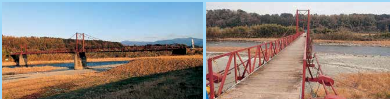
被災前の新村橋
