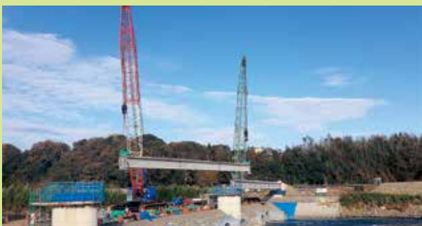
復旧中の様子
