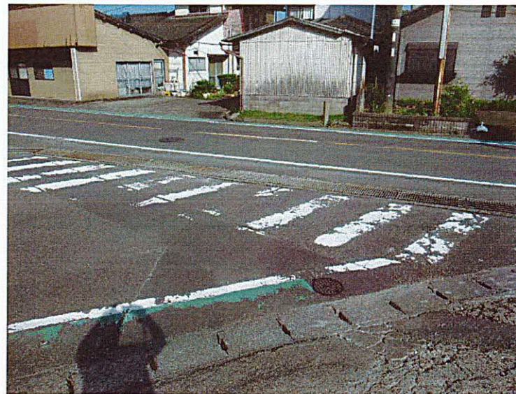
⑤ 南小学校プール側横断歩道 線が薄くなっている (対策) 状況確認後、予算の範囲内で対応を検討する
