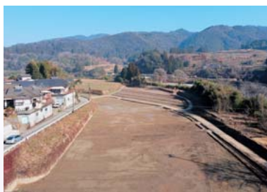
農地の災害復旧工事 (四浦平川地区)
