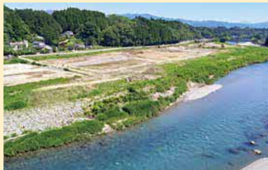
下鶴遊水機能地（県管理区間）
