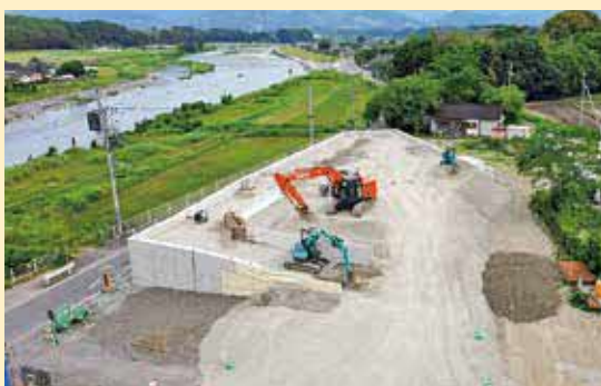
平原地区復興まちづくり支援施設（避難地）
