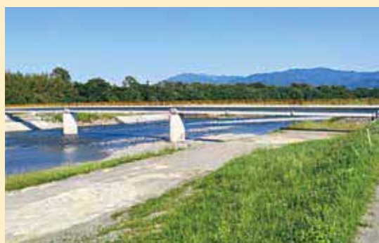
新村橋（令和2年災害復旧）
