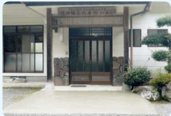
集会場のスロープ設置
