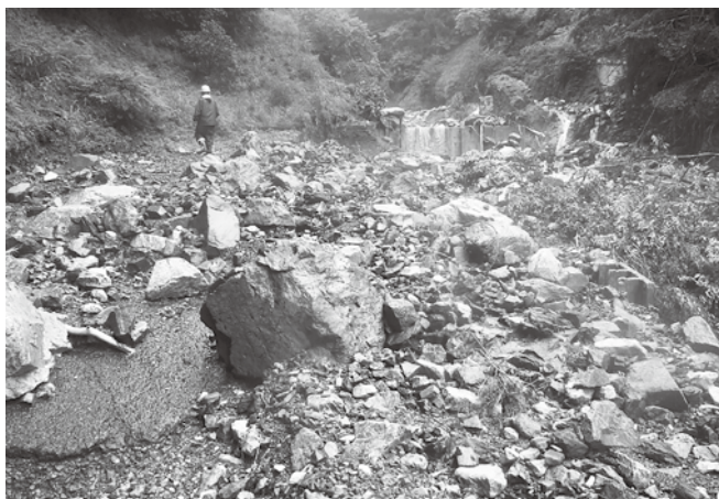
仰烏帽子山に続く林道が崩落(林道相良五木線)
