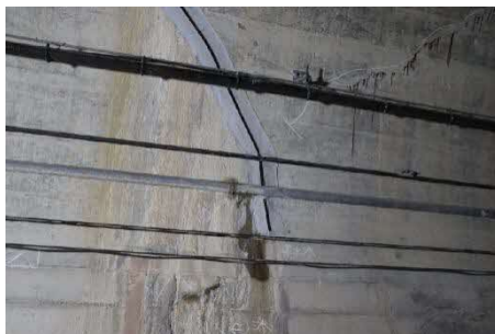
写真 3.4.3) 漏水(滴水)
