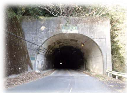
トンネル（人吉側）
