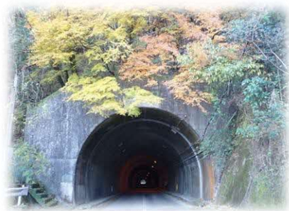
トンネル（椎葉側）
