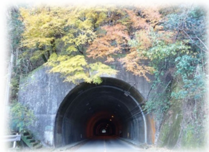
トンネル（椎葉側）
