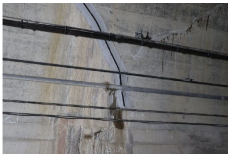
写真 3.4.3) 漏水(滴水)
