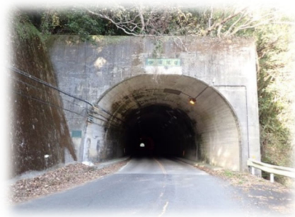
トンネル（人吉側）
