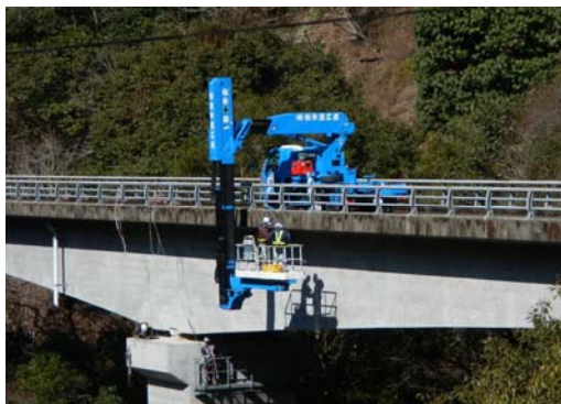
定期点検：橋梁点検車(近接目視)
