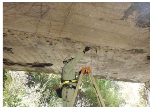
定期点検：梯子(近接目視)
