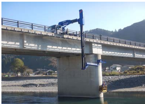
定期点検：ゴンドラ点検車(近接目視)
