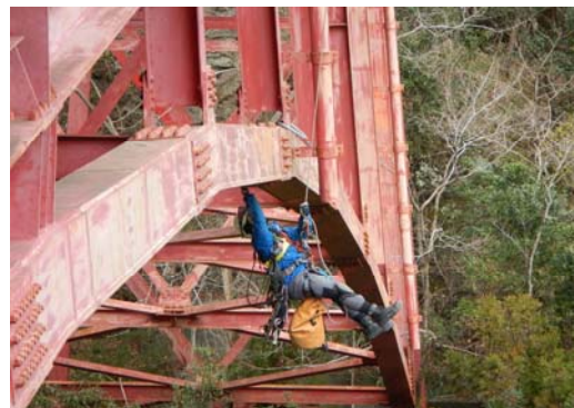
定期点検：特殊高所技術(近接目視)
