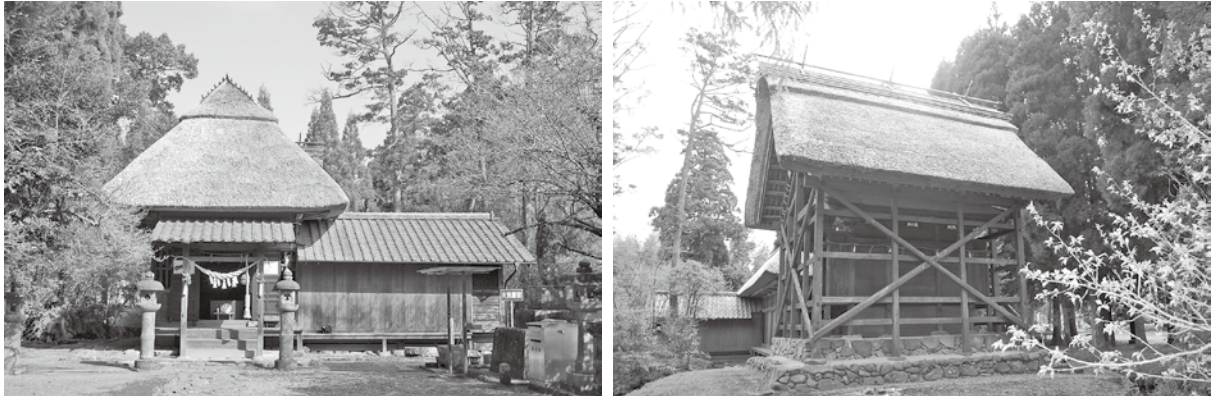
改修された拝殿(左側)と本殿・本殿覆屋(右側)
