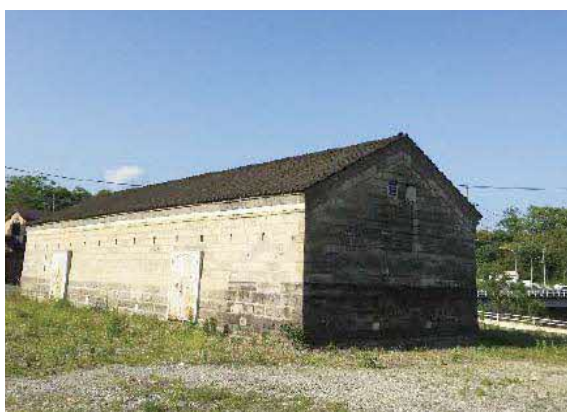
解体前の農業文化遺産としての柳瀬石倉
