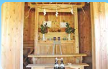
傷んでいた中島神社を改修
