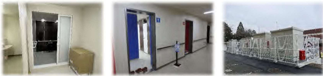
〔写真〕改修された相良村総合体育館
