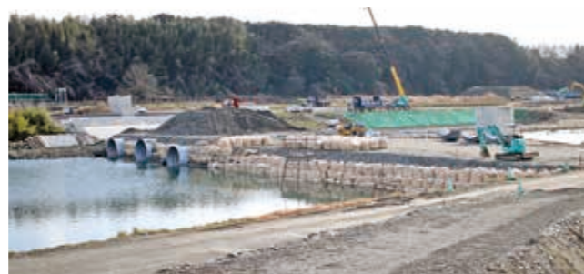
右岸からの様子
