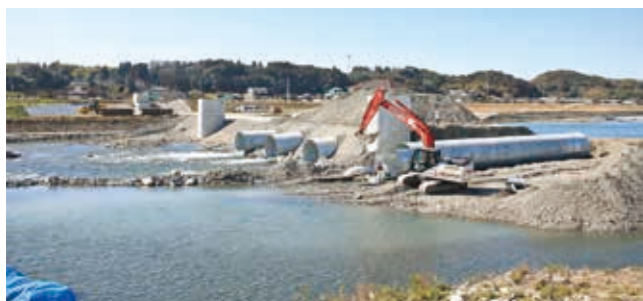
左岸からの様子
