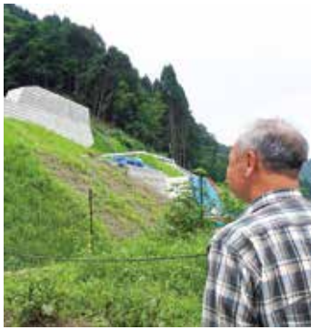
発生現場を見つめる緒方さん 現在は砂防堰堤 えんてい 設置工事中
