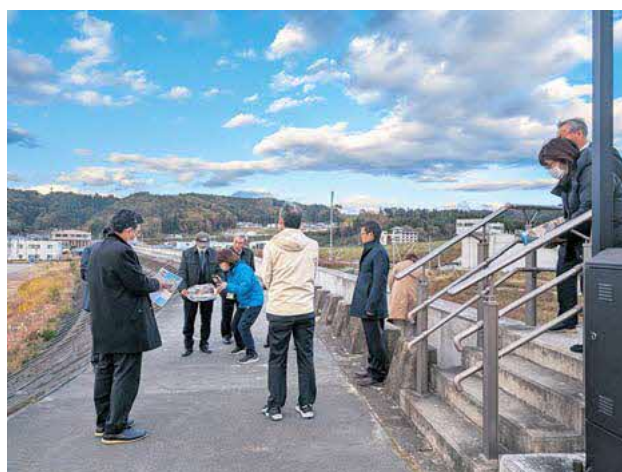
⑤津波遺構たろう観光ホテル（震災遺構）近くの田老防潮堤 （令和5年11月14日）
