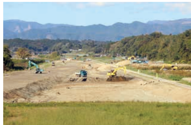
柳瀬地区の遊水地整備の様子
