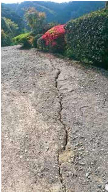
民家庭に入った亀裂
