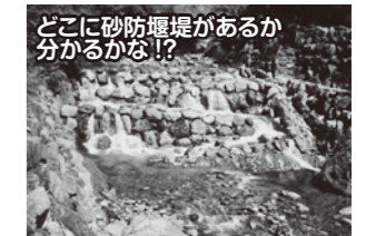
景観や環境に配慮するため、砂防堰堤の表面に現地の巨石を用いています。
