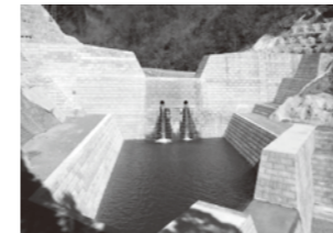
標準的な砂防堰堤。不透過型の重力式コンクリート堰堤と呼びます。
