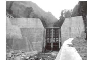
上流側が透けて見えます。透過型の鋼製スリット砂防堰堤と呼びます。
