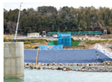
復旧中の新村橋
