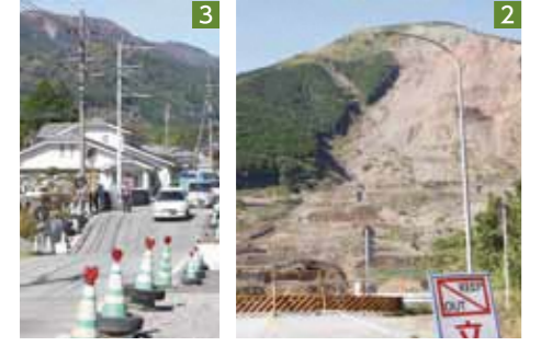
1_倒壊した拝殿(阿蘇神社) 2_崩落した阿蘇大橋と土砂崩れの跡(南阿蘇村) 3_地盤沈下で寸断された道路も現在は通行できる(阿蘇市)
