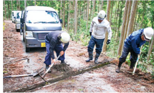
溝の泥を撤去する相良村森林組合の作業員
