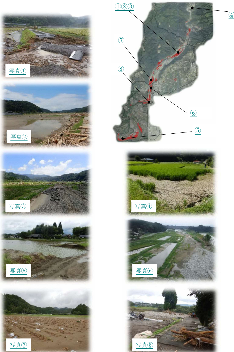
〔写真〕 農地等被害箇所と被災状況
