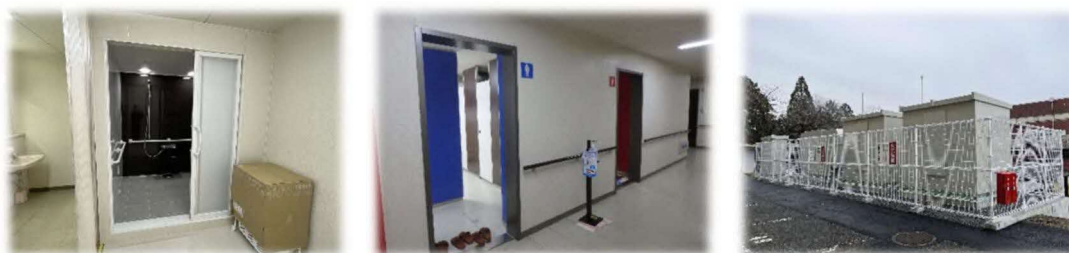
[写真] 改修された相良村総合体育館
