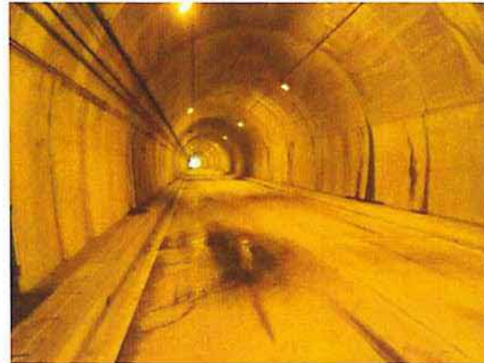
トンネル内状況
