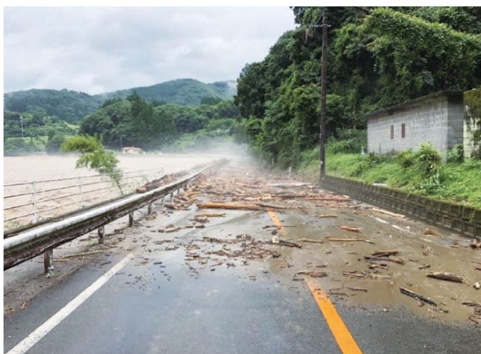
国道445号 上下坂晴山区間の冠水状況
