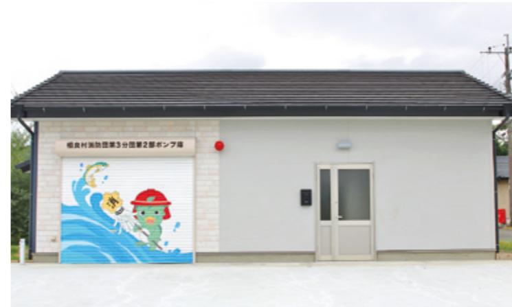
完成した消防詰所
