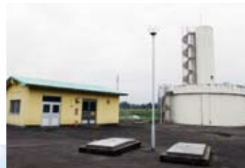
柳瀬地区簡易水道給水施設
