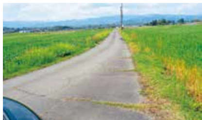
未改良区間の状況
