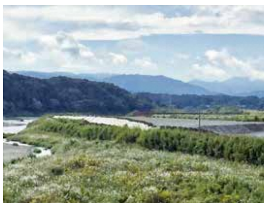
合流点に積まれた堆積土砂～井沢地区
