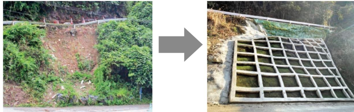
村道中尾線災害復旧工事2 道路崩壊部分を補強土壁工により復旧
