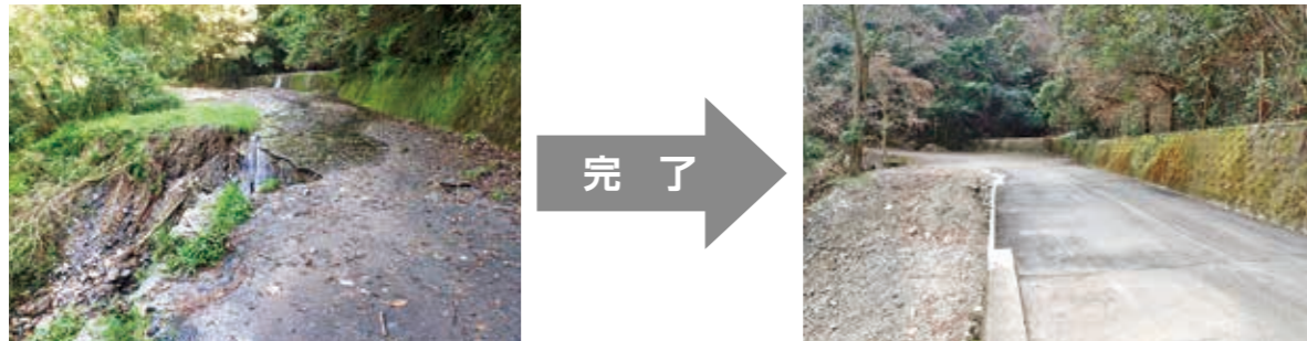
村道初神野原線災害復旧工事 道路崩壊部分をL型擁壁工により復旧
