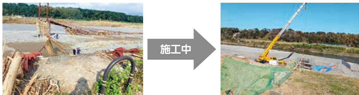
村道新村井沢線新村橋災害復旧工事 右岸の橋脚1基・橋台1基を施工中
