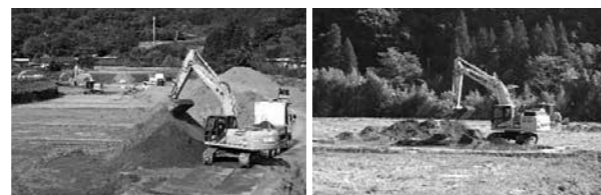
[工事箇所(R3.11.1現在)]
