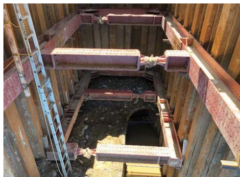
被災した飛行場用水路の開削状況
