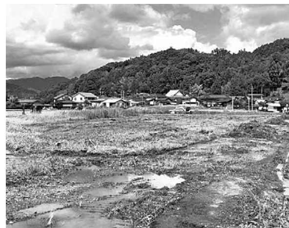
復旧工事が進む農地(上圖)
