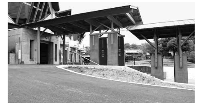
玄関前で直接乗降できるスロープ
