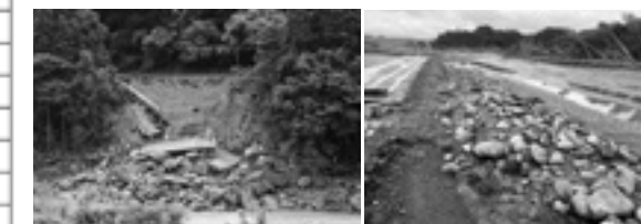
崩壊した道路 (村道永江瀬線)
