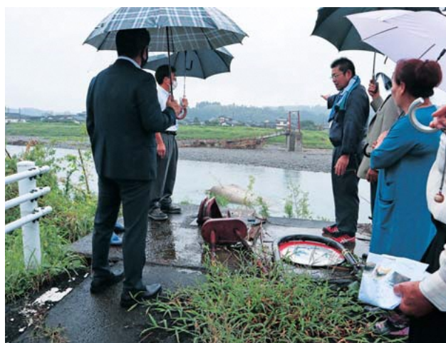
大字柳瀬 新村橋（字 中洲から）：橋梁の流失
