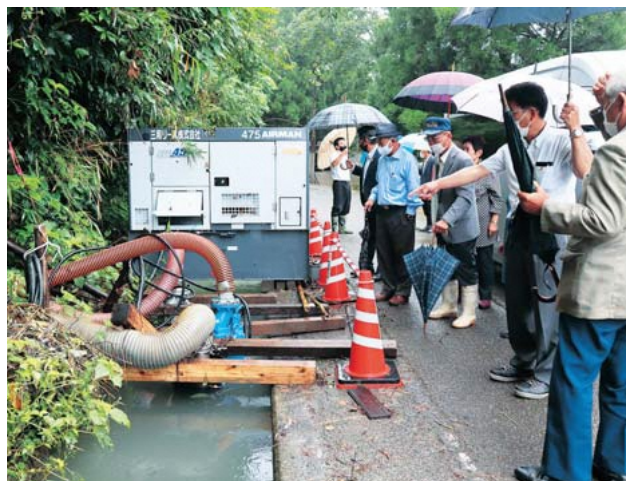
棚葉瀬地区ポンプ揚水所付近：仮設ポンプによる揚水
