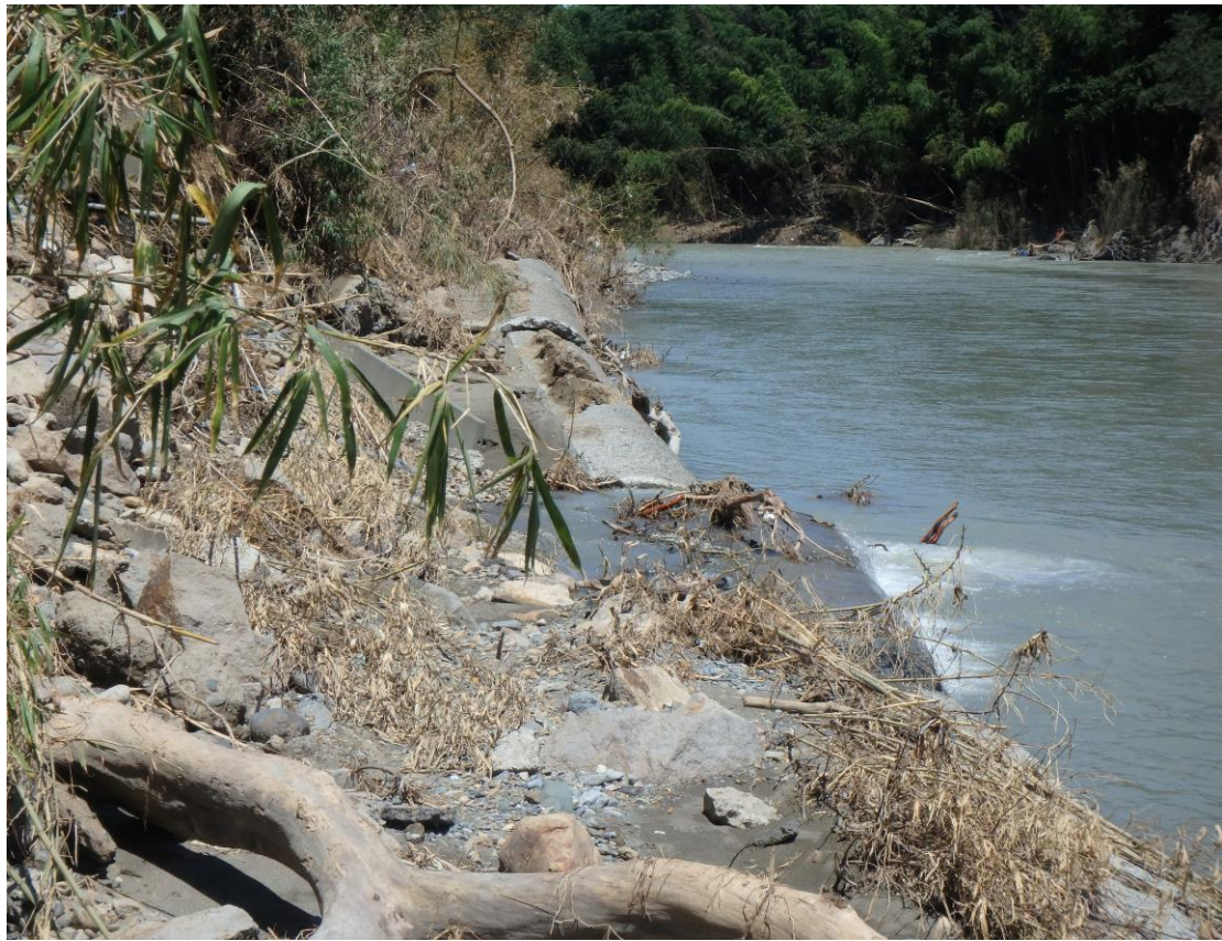
柳瀬＞大曲（水路崩壊）
