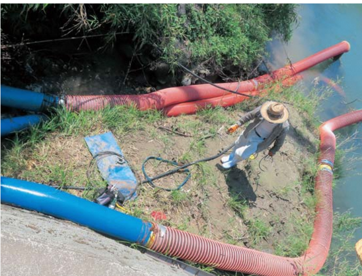
飛行場水路に対する用水状況(2ヶ所 5台)
