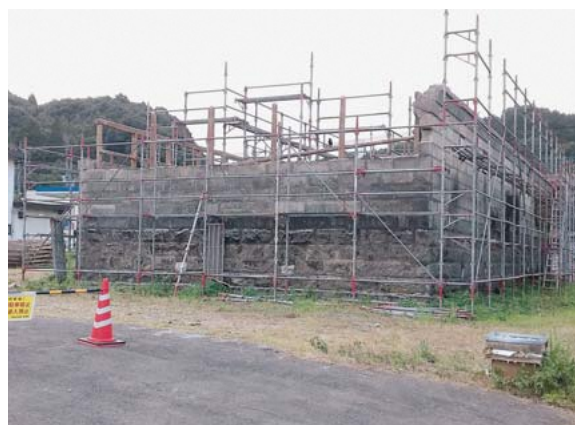
柳瀬石倉解体状況(8月7日撮影)
