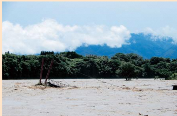
新村橋の被災状況（7月4日）
